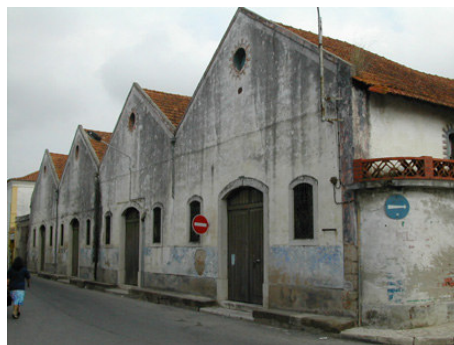
Edifício da Rua Dias Neiva, nº 20A a 22 (Q18 L1)
