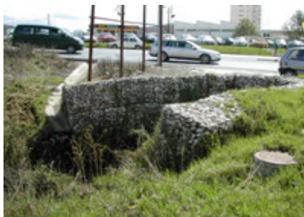
Figuras 7 e 8 – Confinamento da Vala e secção de superfície fechada
