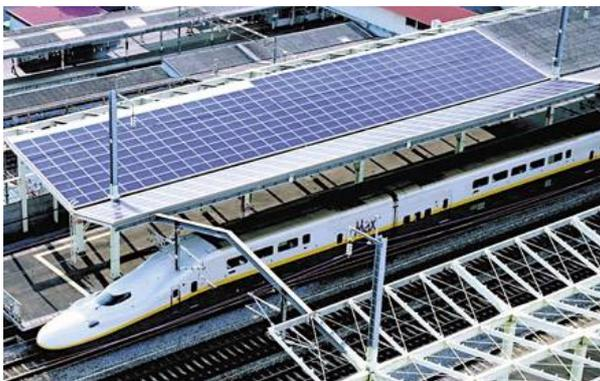
**Figura 70** – Estação de comboio que usa painéis solares como protecção contra os agentes climatéricos.<sup>75</sup>
