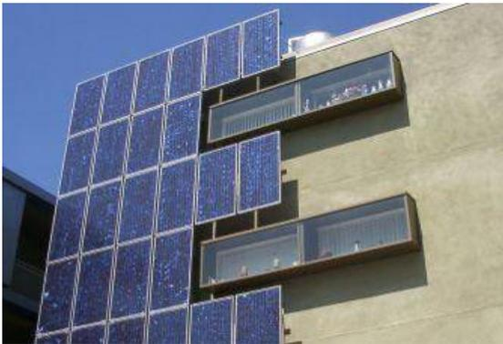
**Figura 72** – Edifício em Santa Mónica que painéis solares para aquecimento de águas sanitárias.<sup>77</sup>
