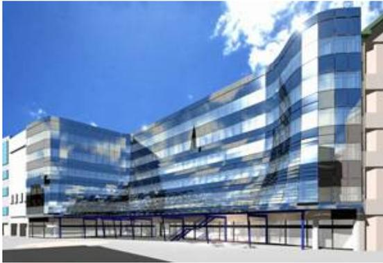
**Figura 71** – Revestimento Fotovoltaico proposto para um edifício de serviços na Alemanha<sup>76</sup>
